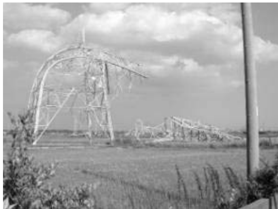
写真1 2002年台風21号により倒壊した鉄塔
