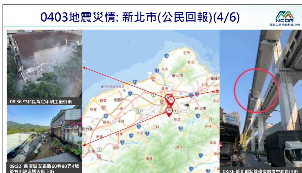
■ 図3 鉄道被害の状況（下図右側の写真に高架橋被害が示されている。）
