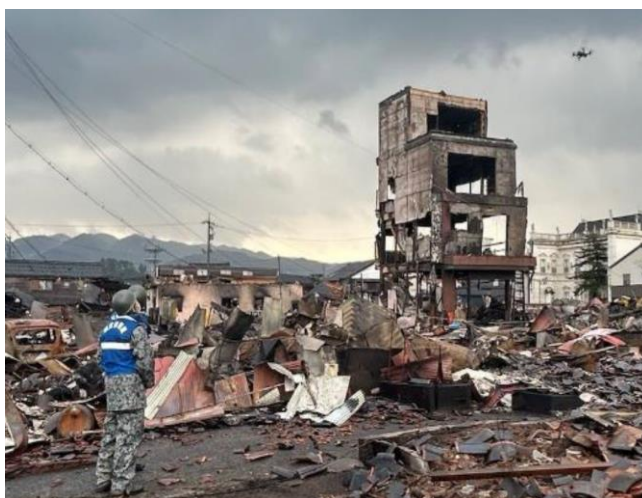
■ 写真1 能登半島地震の被害
