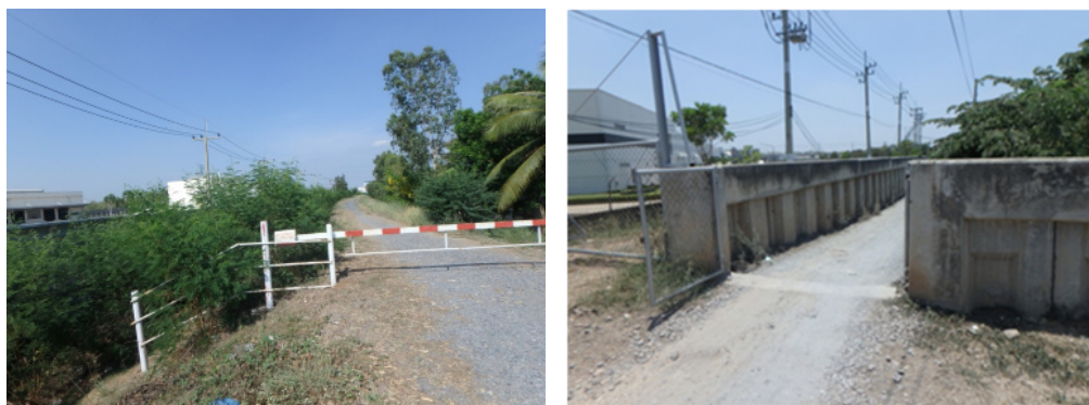
■ 図6 工業団地の浸水対策（左：土堤による高上げ、右：工場入口（1.4m））（弊社撮影）
