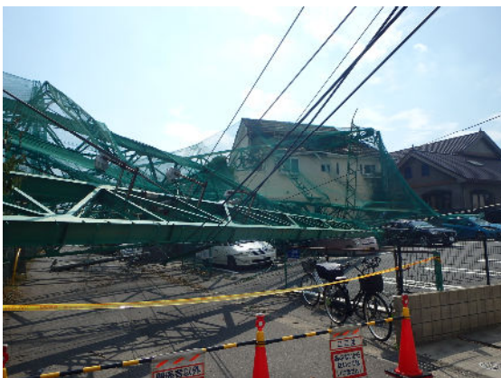
■ 写真 7 倒壊したゴルフネット
