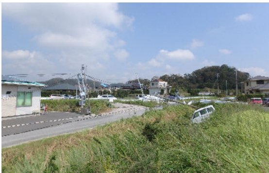
■ 写真 13 倒壊した電柱
