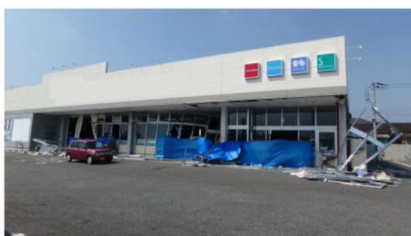
■ 写真 21 ガラスの飛散したドラッグストア
