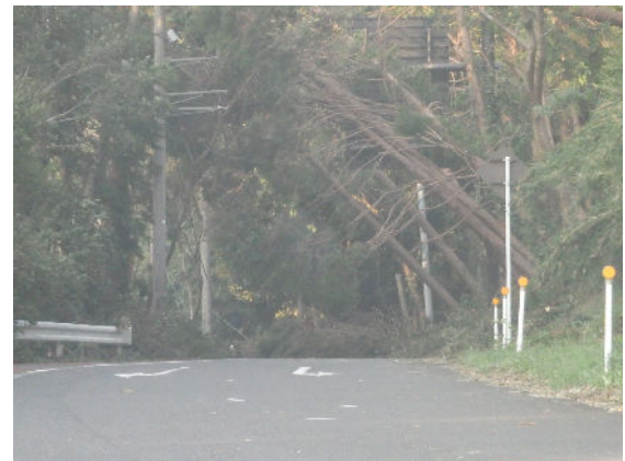
■ 写真12 倒壊した鉄塔周辺の倒木
