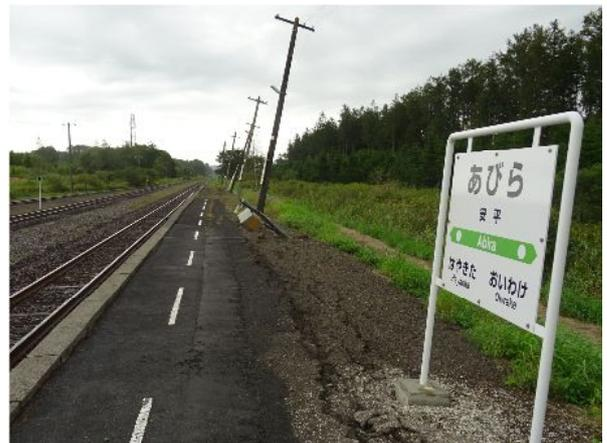
写真4 ホームの電柱傾斜
