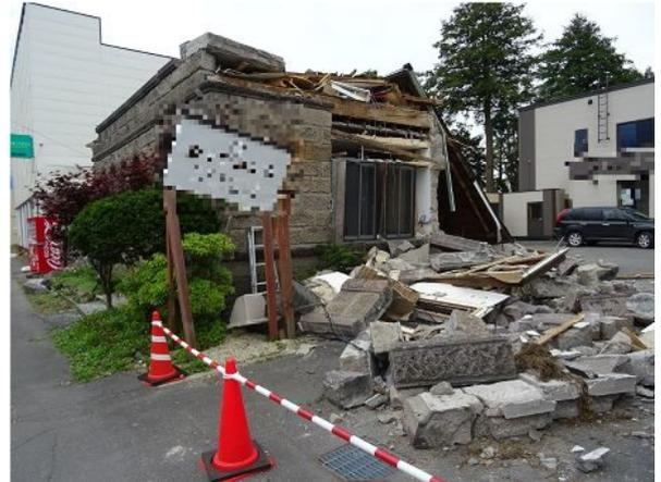
写真2 積石造建物の倒壊（安平町）
