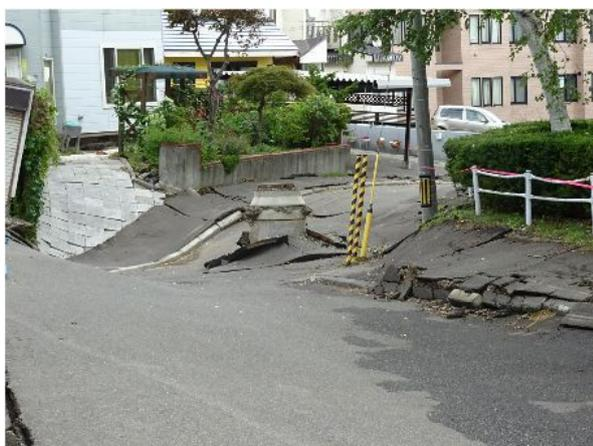
写真5 液状化による地盤沈下
