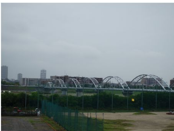
写真11 漏水した水道管（枚方水管橋）
