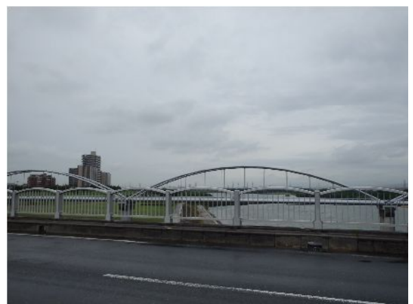
写真12 漏水した水道管（枚方水管橋）
