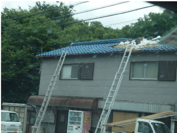
写真9 補修中の屋根
