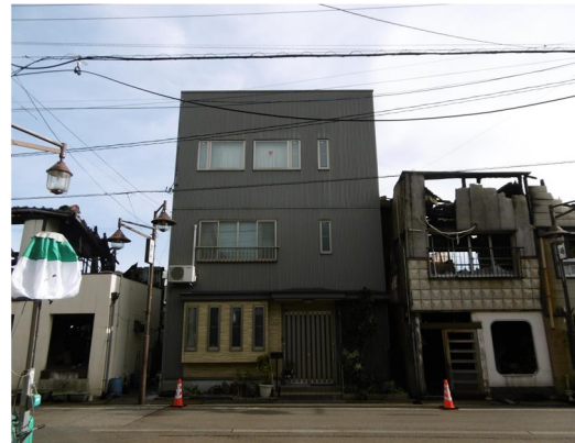
■写真4 被害の見られない家屋 (ともに外壁に金属系サイディングボードを使用)
