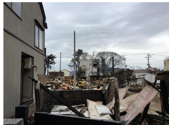
■写真6 庭が設けられた家屋 (右手方向からの延焼を防止)
