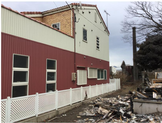
■写真4 被害の見られない家屋 (ともに外壁に金属系サイディングボードを使用)
