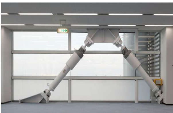
■写真1 ダンパー（オイルダンパー）設置
