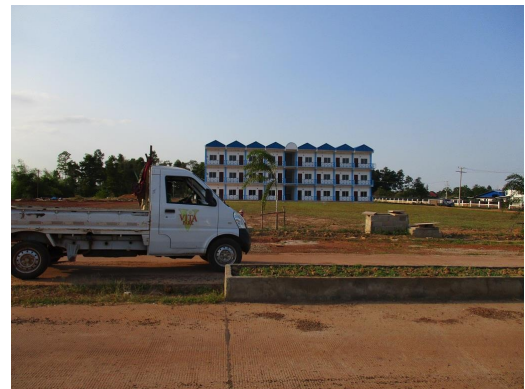
■写真5 ビタパーク内に建設中の寮
