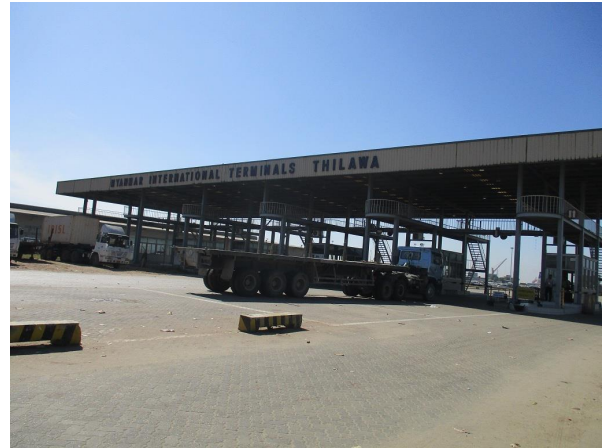
■写真3 ティラワ港の入口ゲート
