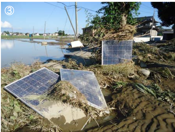
③越水地点周辺：太陽光パネルの流出が見られた
