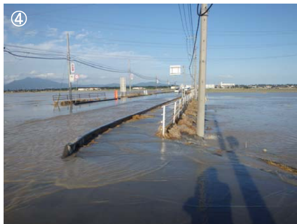
④浸水域内の道路：冠水により通行困難(常総バイパス付近)
