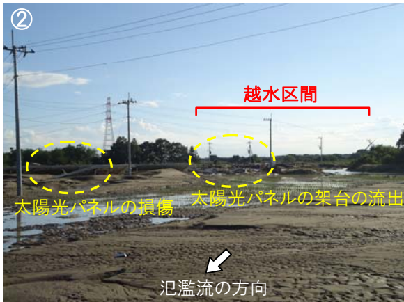
②越水地点周辺：太陽光発電施設に大きな被害が見られた
