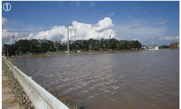
①浸水域の北端：水田が浸水している
