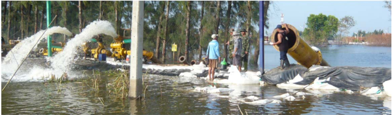
■ 図3 ハイテク (Hi-Tech) 工業団地 (アユタヤ県) での排水作業の様子 (2011年11月弊社撮影)
