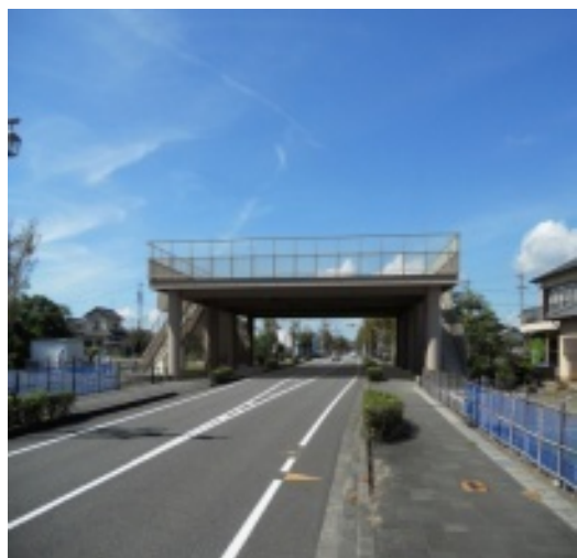
■写真1 津波避難タワーの例
