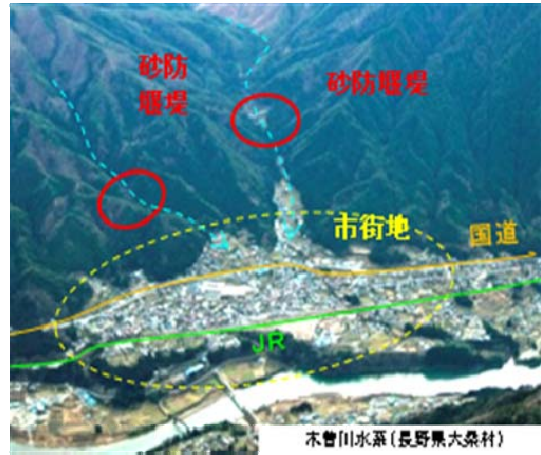
■写真3 重要交通網を保全する砂防設備の例
