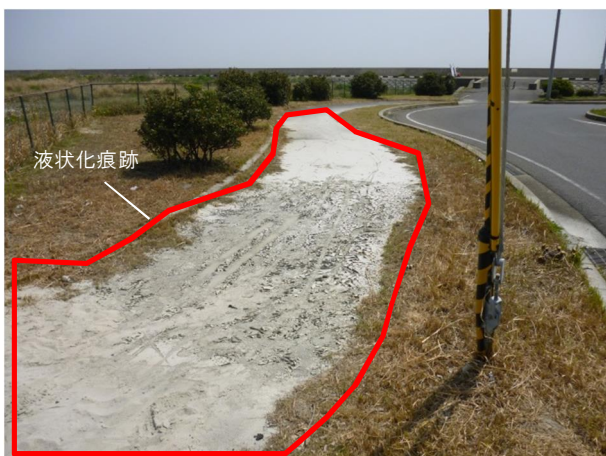
■写真1 埋立地における液状化被害
