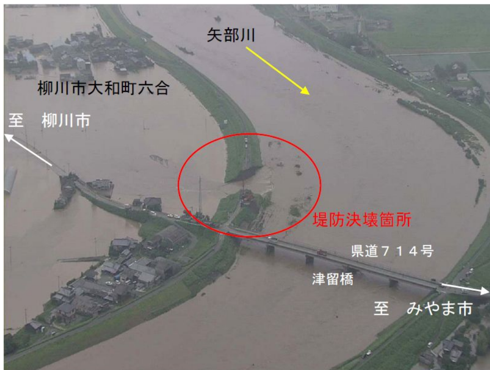
写真 1. 矢部川の堤防決壊箇所と氾濫の状況（福岡県柳川市大和町）
