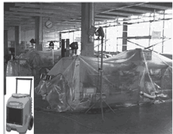
写真-2 除湿による緊急安定化処置
