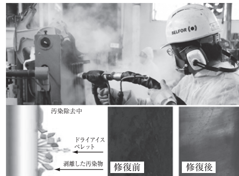
写真-5 アイス・ブラスターによる汚染物の除去
