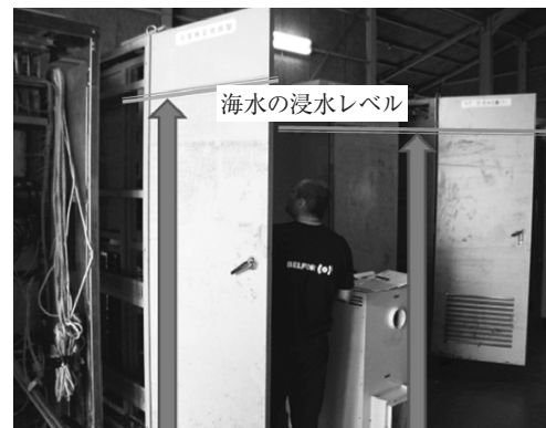
写真-1 東日本大震災で被災したキュービクルの修復
